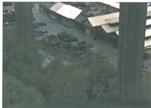
Mur de l'usine en rive droite à Passy
